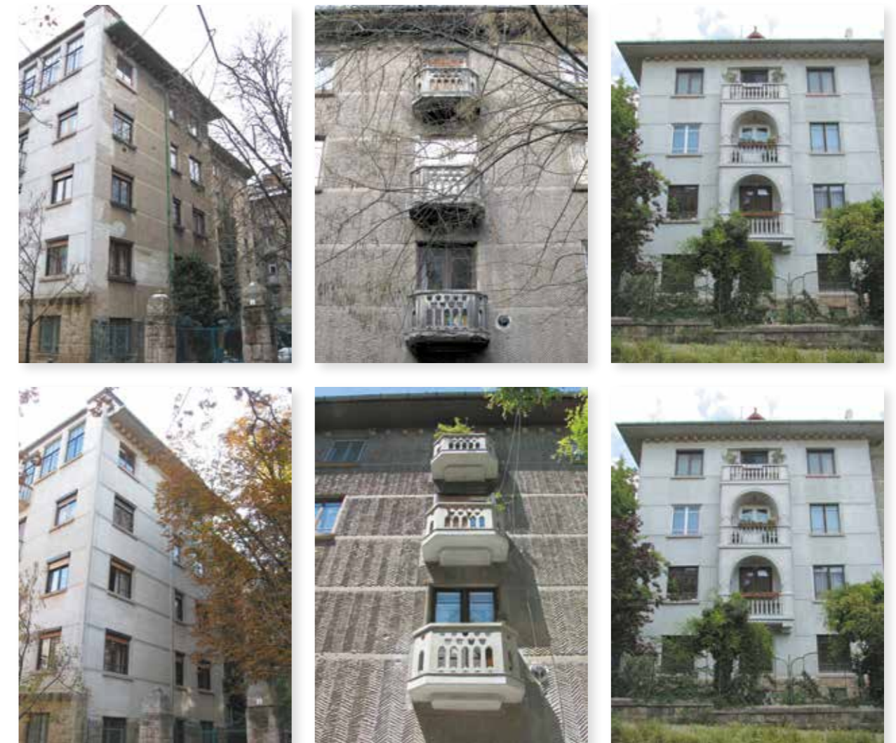
Különleges homlokzatvakolatok újrakészítése és erkélyek felújítása. XII. kerület, Kiss János altábornagy utca 55-59.
