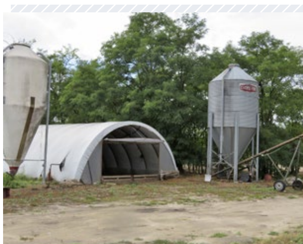
5. kép: Móricgát, fóliaborítású libahízaló épület. A mobilis (könnyen bontható, áthelyezhető) épületek és berendezések a gyors profilváltást is lehetővé teszik 8 .
